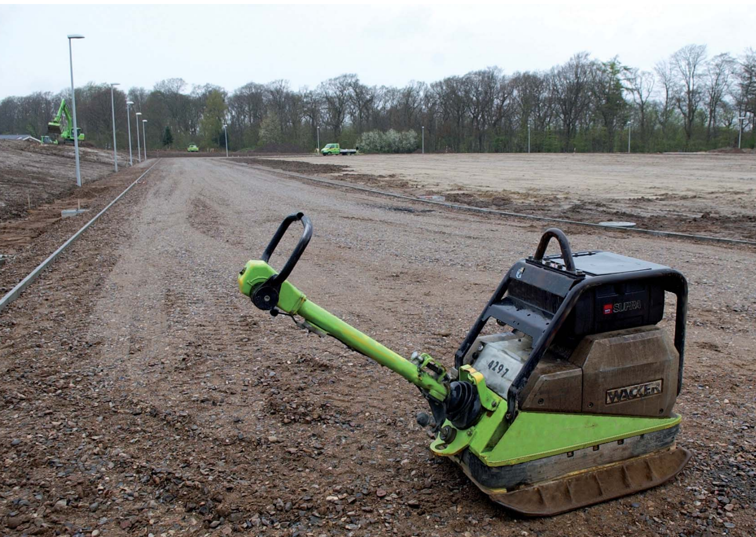
Der var gang i både små og store maskiner ved arbejdet ved siden af Vejen Idrætscenter.
