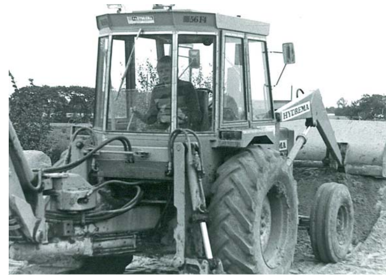
Der er gang i jordarbejdet i en Hydrema 56F4 med Hans Jørgen Frisesdahl ved styrepinden.
